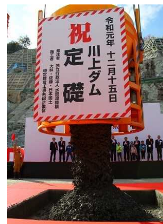
コンクリート投入
